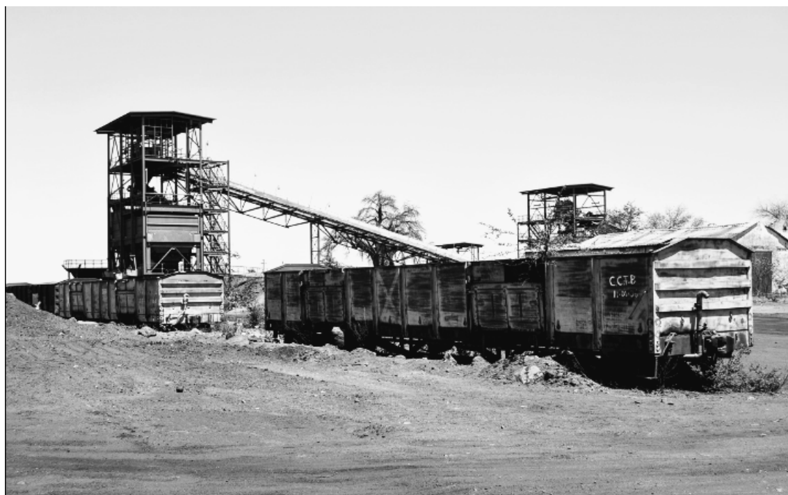
Foto. 3 - Local onde o carvão foi carregado pela Mozambique Coal Company. Fonte: Autor
