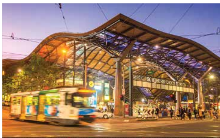
Estação Southern Cross Melbourne, Austrália
