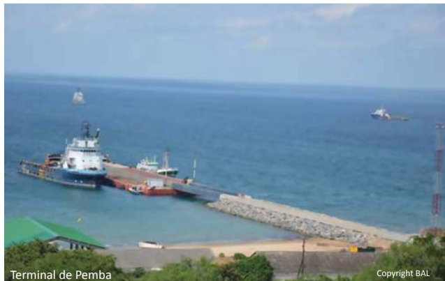
Terminal de Pemba
